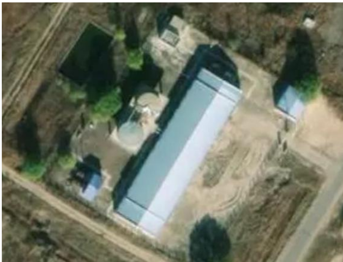
南二东 3 号注入站
