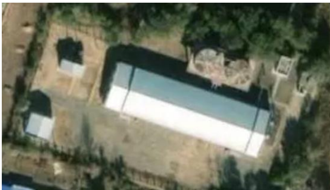
南二东 2 号注入站
