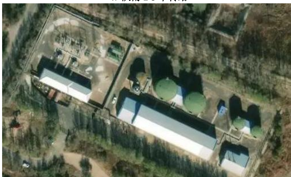
一区注水变电队
