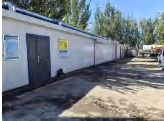
危险废物贮存库（2）
