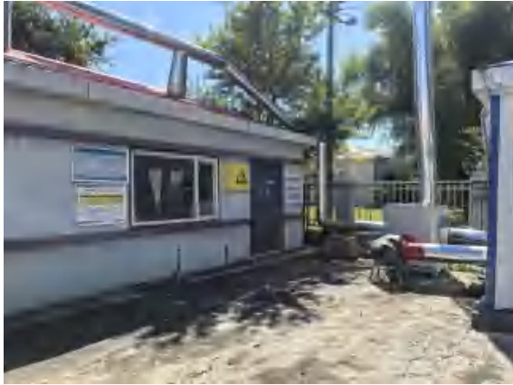
危险废物贮存库（1）
