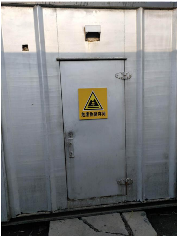
危险废物暂存间
