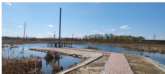
新建 82m 长巡检路现状
