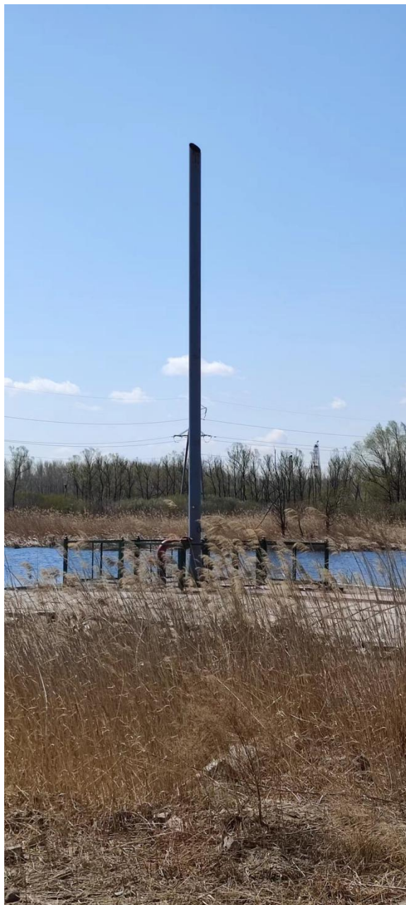
新建管道生态恢复现状
