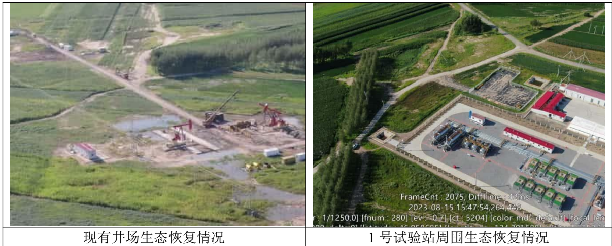
图 3.2-1 现有工程生态恢复情况
