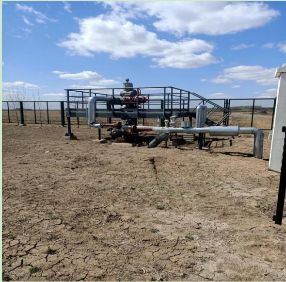
四库 1 井场恢复现状
