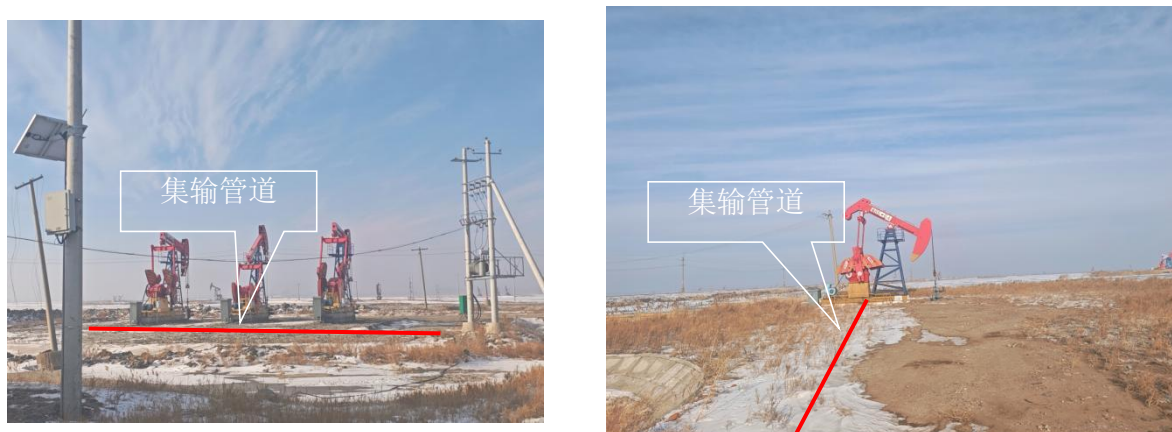
图 3.1-1 区内已建集输管道临时占地恢复情况
