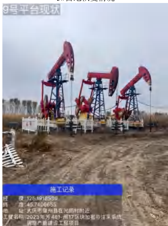
9#平台占地恢复情况
