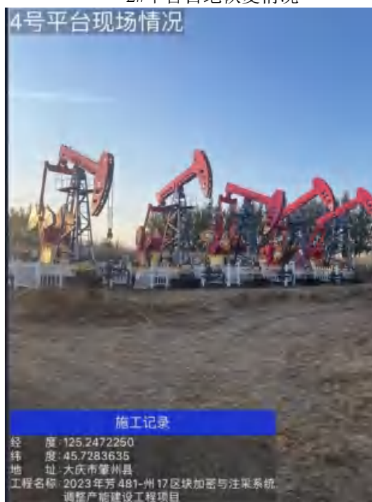
4#平台占地恢复情况
