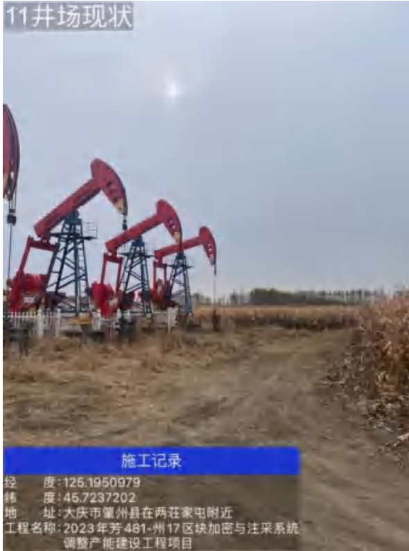
11#平台占地恢复情况
