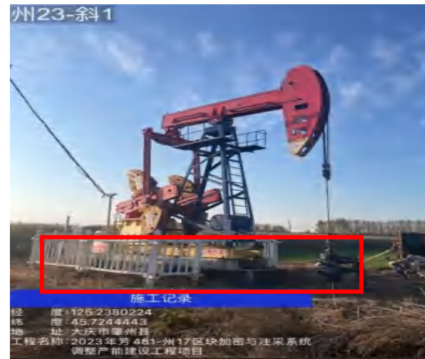
州 23-斜 1 抽油机减震基础
