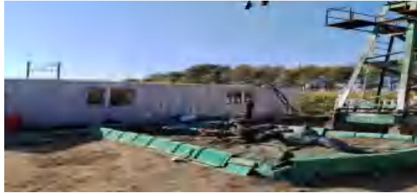
井口安装回收装置铺设防渗布 图 6-1 油井作业措施
