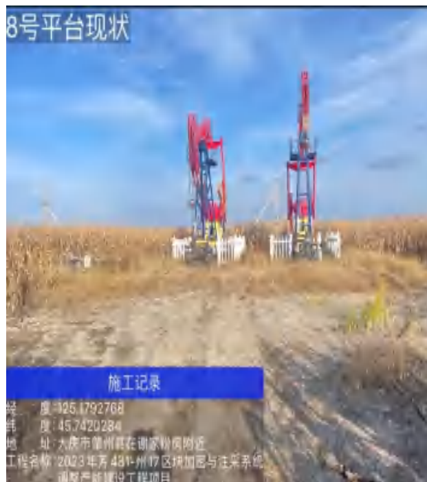
8#平台占地恢复情况
