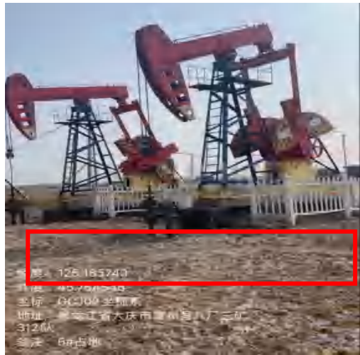
6#平台抽油机减震基础
