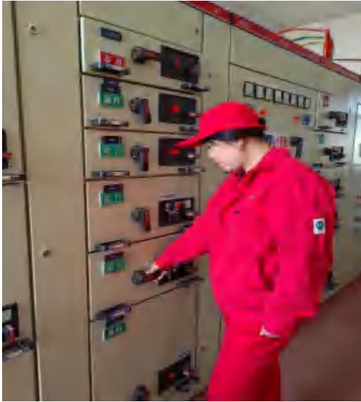
巡检人员定期巡检照片
