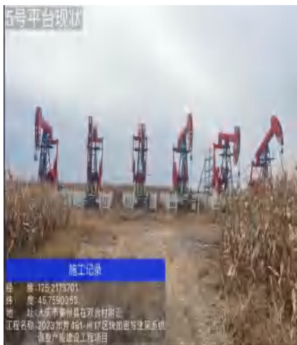
5#占地恢复情况
