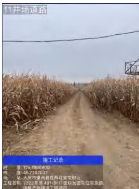
11#平台通井路占地恢复情况
