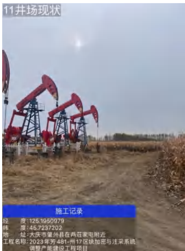
11#平台占地恢复情况
