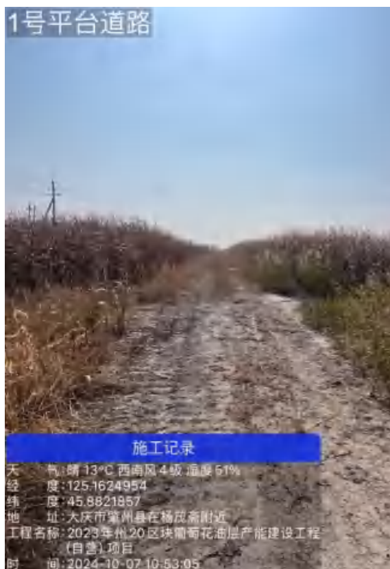
1#平台井道路现状
