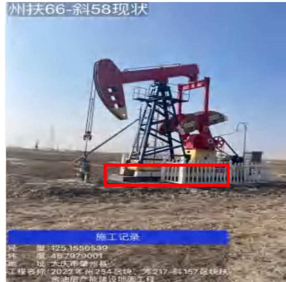
州扶66-斜58抽油机减震基础
