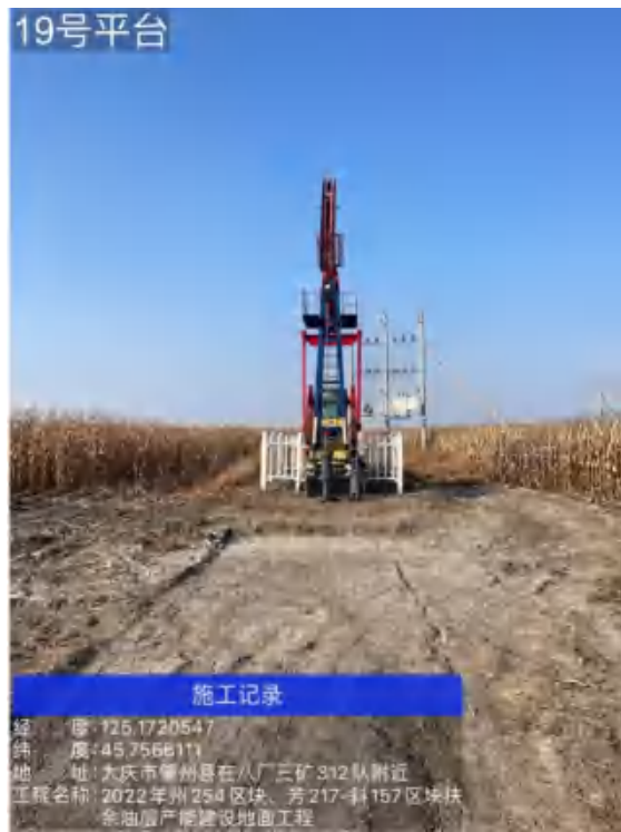
19#平台占地恢复情况
