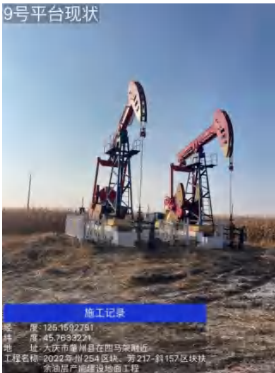
9#平台占地恢复情况
