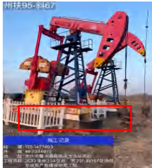
15#平台抽油机减震基础
