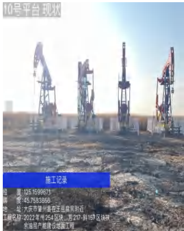
10#平台占地恢复情况
