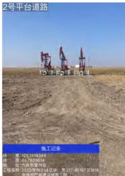
2#平台占地恢复情况
