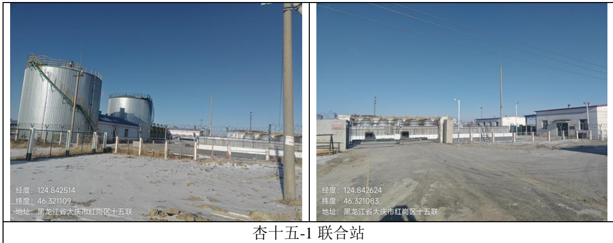
图 3.1-1 杏八区纯油区内井场及场站建设情况
