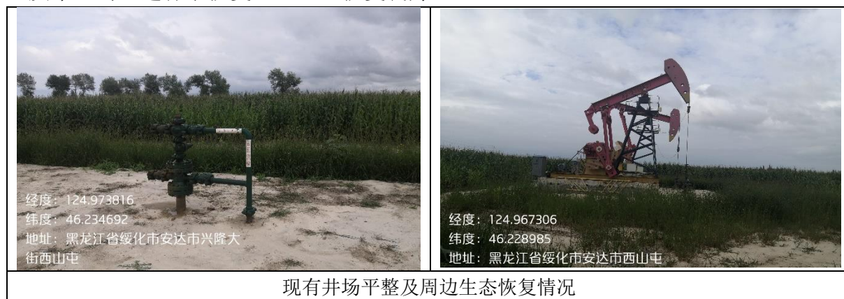
图3.1-2 现有区块内已建井场及管线周边生态恢复情况
