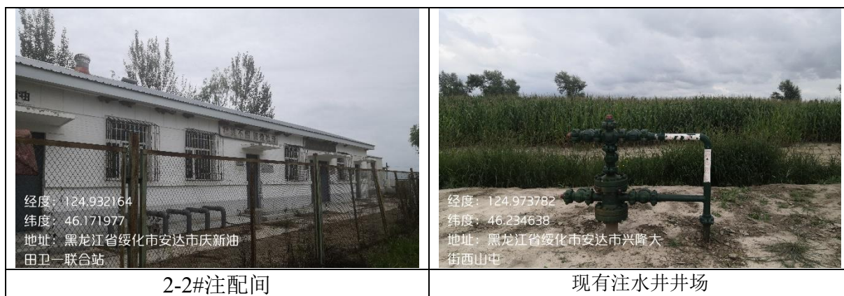
图 3.1-1 现有区块内井场及注配间建设情况
