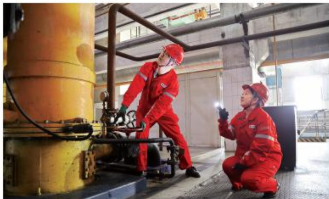
近日,电脱公司热电一公司运行部员工对油井注水安全设备进行安全专项检查,排查安全隐患,保障生产安全。
