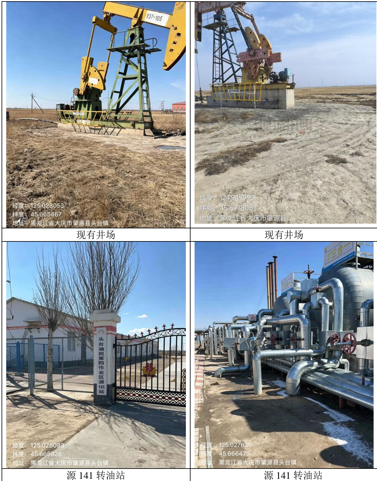
图 3.1-3 源 23 区块内井场及场站建设情况
