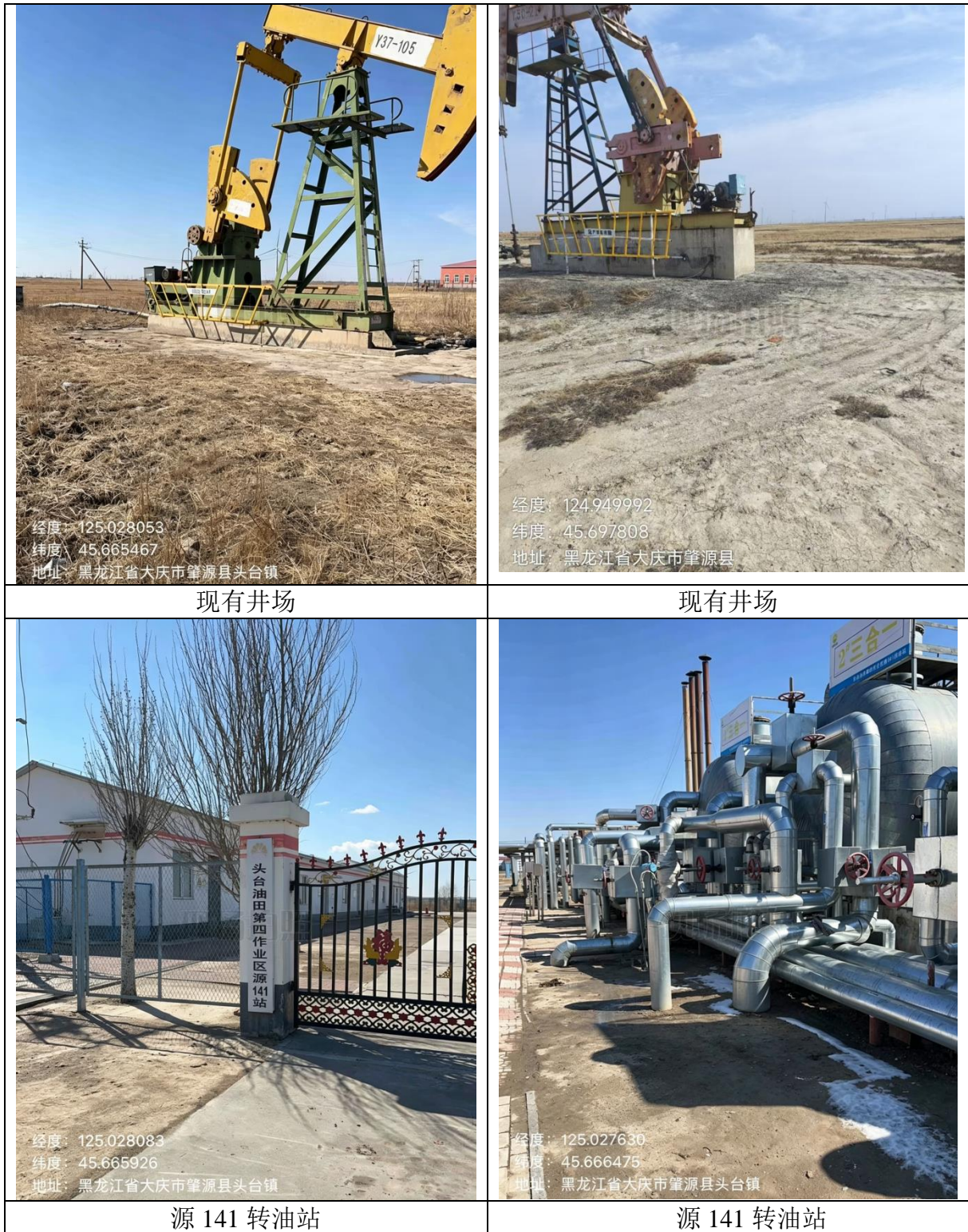
图 3.1-3 源 23 区块内井场及场站建设情况
