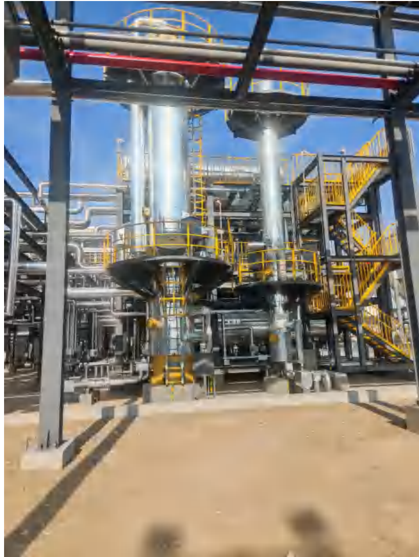
吸收塔、换热器
