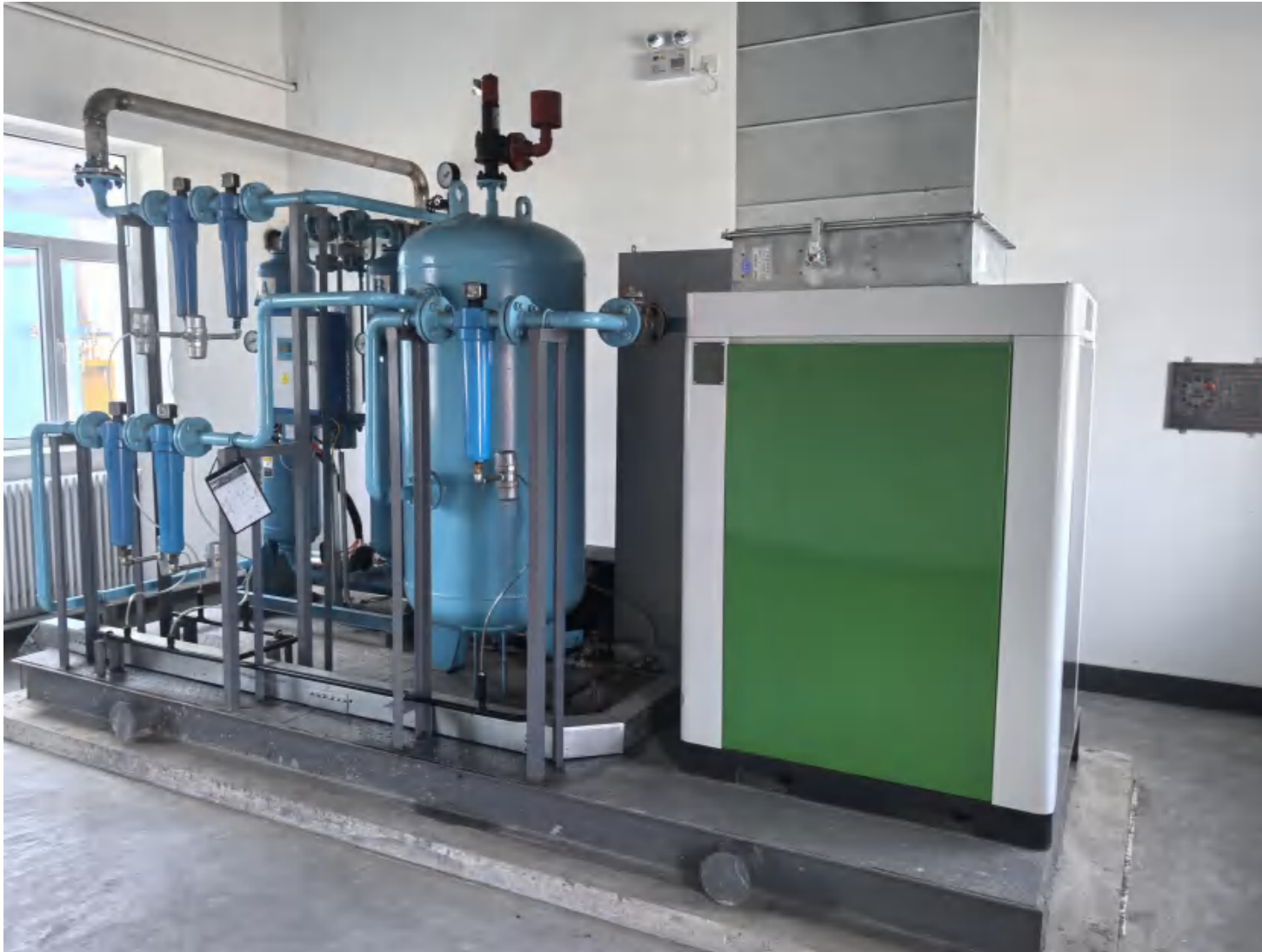
压缩机、储罐
