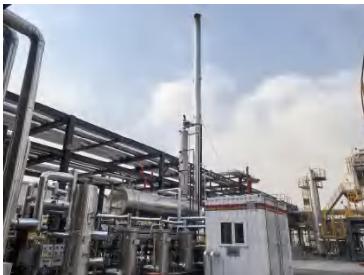
配套低氮燃烧器，烟气通过18m高烟囱排放（编号DA001）
