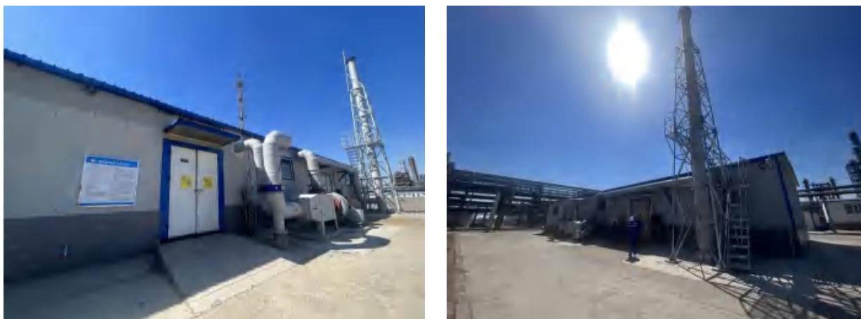
危险废物暂存间图
