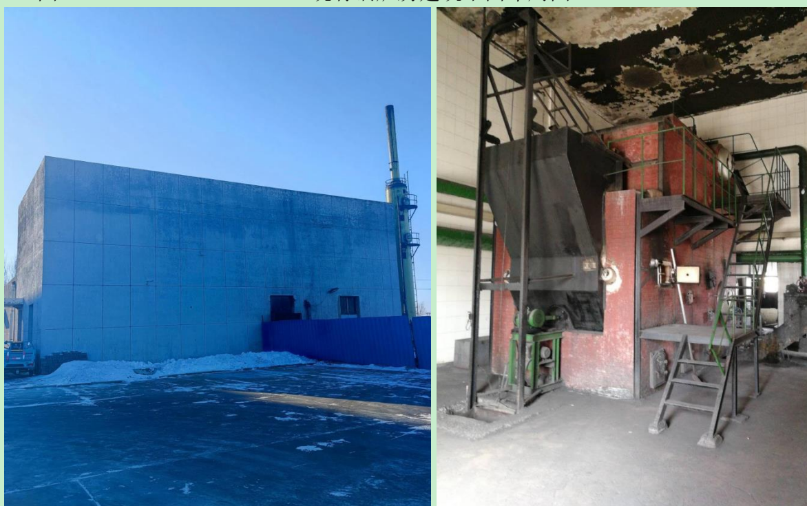
图 3.1-3 锅炉房外观及燃煤锅炉现状图
