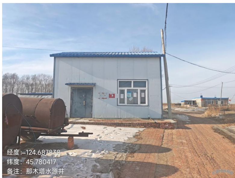
图 2.5-1 那木塔水源井现状照片
