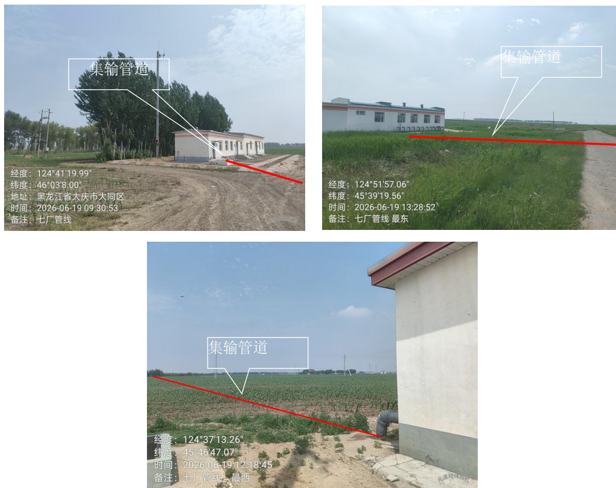
图 3.1-1 区块内已建集输管道临时占地恢复情况
